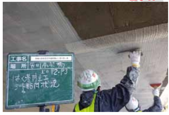
常磐自動車道吉川高架橋はく落対策工事の様子
