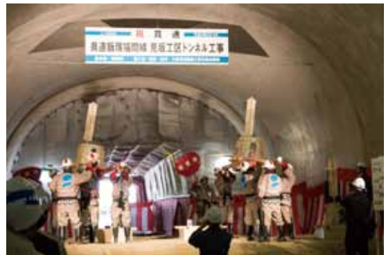
見坂トンネル工事の貫通式
